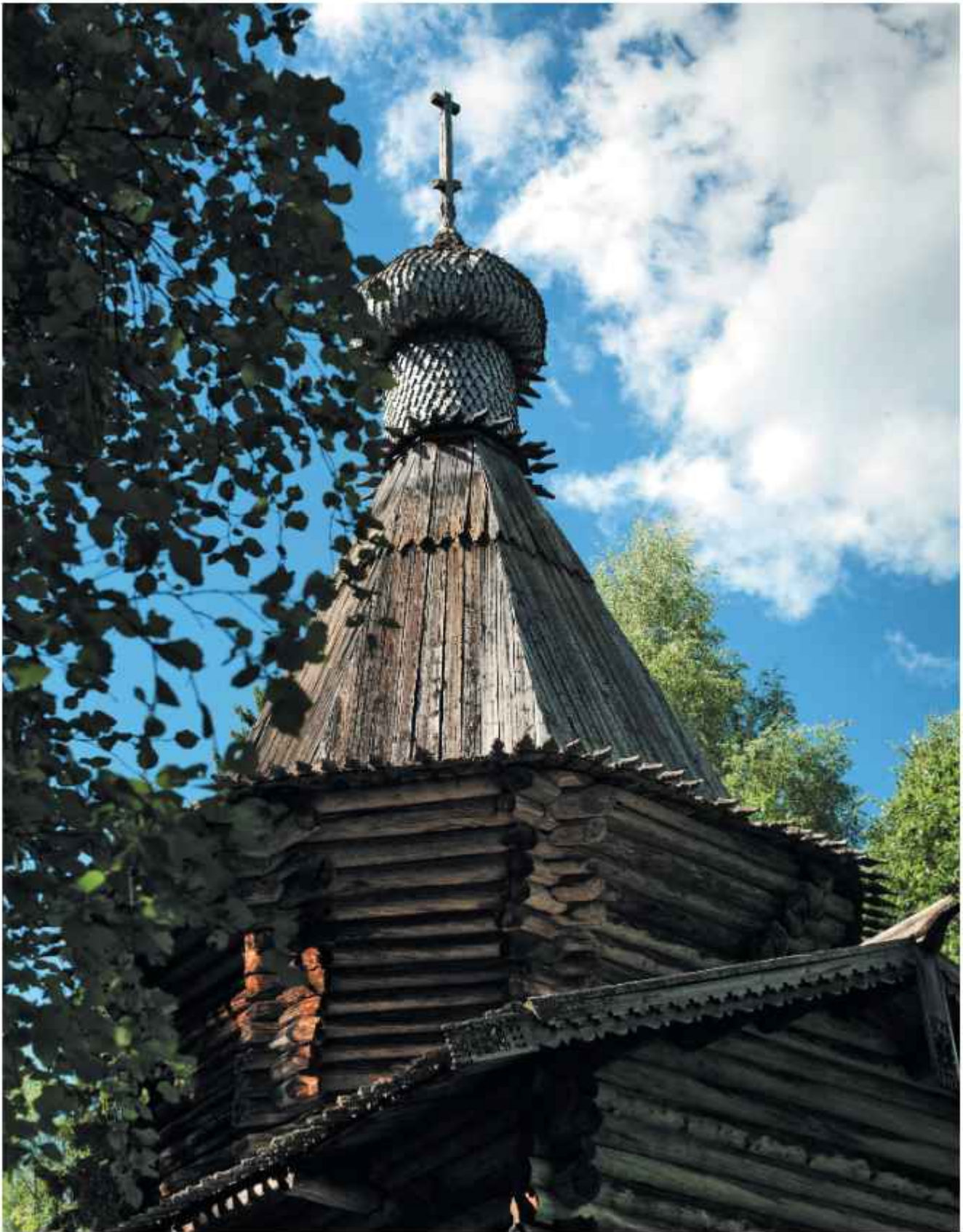
Никольская церковь Троицкого монастыря до реставрации, начало XVII века
