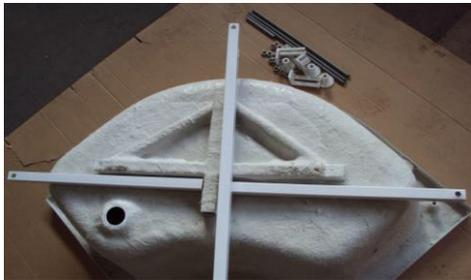
Б) Установите поперечины подвижных частей каркаса в пазы стационарного каркаса поддона таким образом, чтобы отверстия подвижного каркаса находились в одной плоскости с верхними креплениями для шпилек на поддоне.
