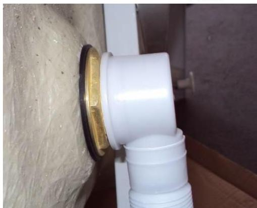
Установите на поддон сливной клапан и стакан с гофрой (если предусмотрен конструкцией вашей модели) так, чтобы резиновая прокладка находилась между поддоном и фиксирующей гайкой.
