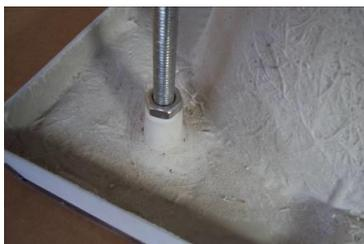
Д) Установите уголки крепления экрана и зафиксируйте их.
