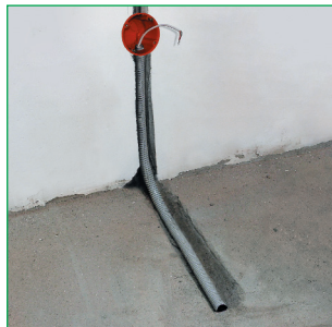
▲ При замене термодатчика не потребуется вскрывать пол
