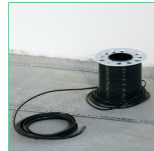
Монтажная лента уложена
