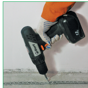
Закрепить монтажную ленту
