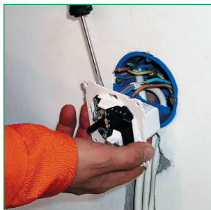
Подключение терморегулятора
