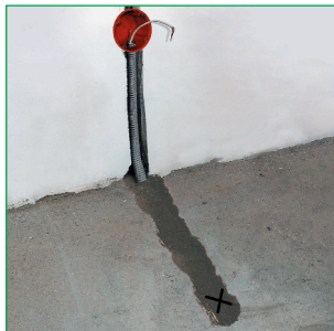
▲ Метка понадобится при укладке кабеля
