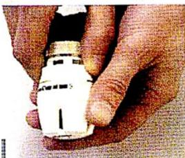
Для упрощения установки термостатической головки поверните селекторный переключатель в положение «5».
