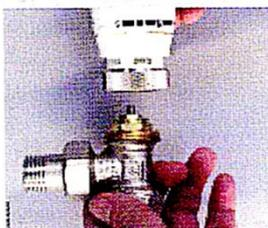
Навинтите кольцо термостатической головки на резьбу вентильной головки.
