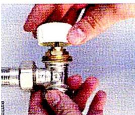
После этого отвинтите предохранительный колпачок, установленный на клапане.
